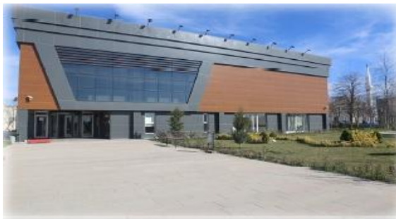
Sosyal Hizmet Binası
